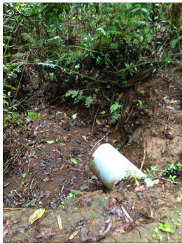
Photo 19 : Passage busé sur site Fetuna
