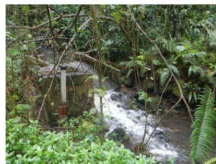
Photo 13 : Ancien captage du SDR abandonné au nord de FAAROA 2
